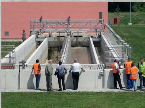
Puštanje prve vode na uređaj-30.5.2011.g.
