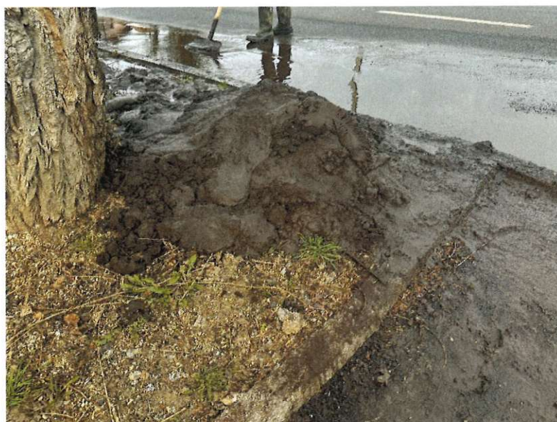
Slika 33: Naslage iz cjevovoda
