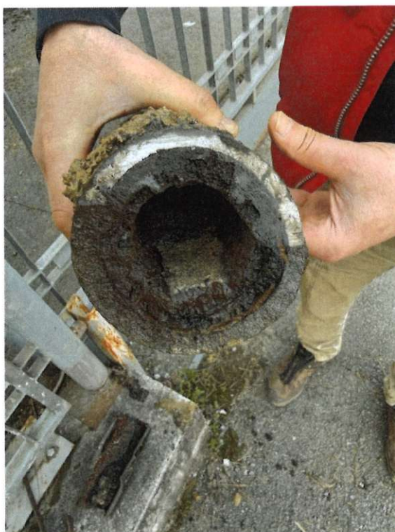
Slika 37: Demontirani dio cjevovoda (Slobodni presjek cijevi: 40 mm)
