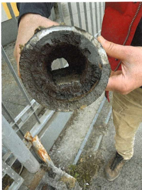
Slika 36: Demontirani dio cjevovoda (Slobodni presjek cijevi: 40 mm)
